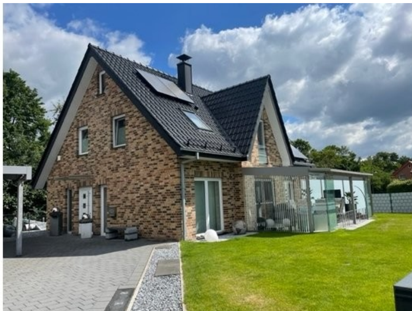
Die großzügige Auffahrt mit Doppel-Carport
