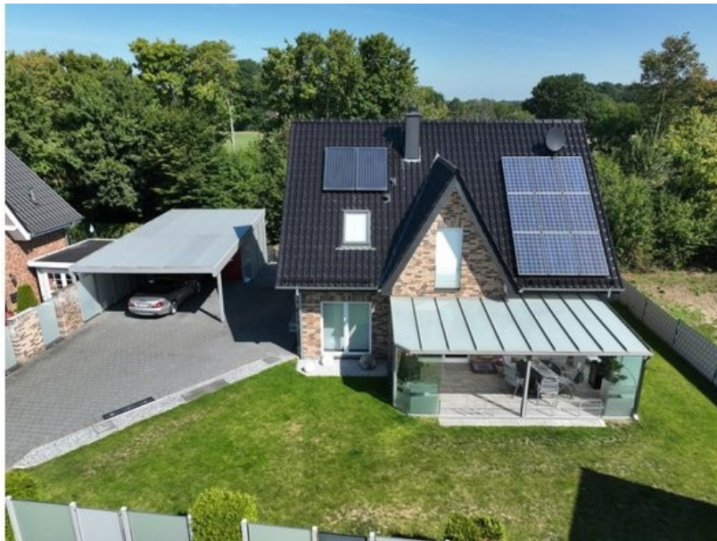
Blick auf die PV-Anlage, Solarthermie und Wintergarten
